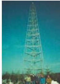
Trigonometrisches Signal (Stahlurm): Stahltürme in Elementbauweise wurden bis 1993 bei Messungen im TP-Feld verwendet.
