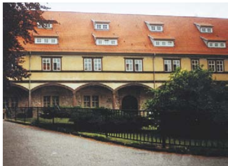
Das alte Gebäude des Katasteramtes Arnstadt, das dort im Erdgeschoss untergebracht war
