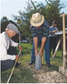
Hier wird der Grenzpunkt mit einem Grenzstein abgemarkt.
